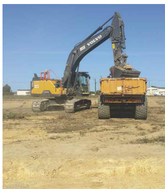
Démarrage des travaux de la ZAC Vallon des Fresches – secteur du Tertre
