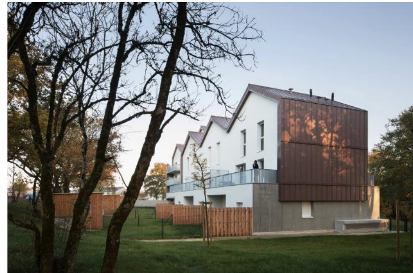
Bâtiment collectif avec combles
