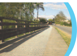
> P5 Travaux sur la passerelle
