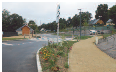
Aménagement du pont
