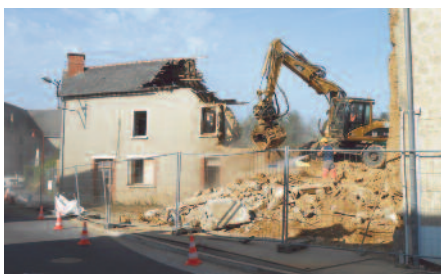
Démolition îlot Chotard
