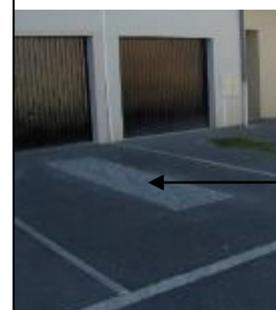
bande engazonnée ou gravillonnée entre les bandes de roulement des véhicules
