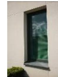
Bavette de protection, appui de fenêtre
